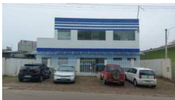
FOTO DA FACHADA CAPS
