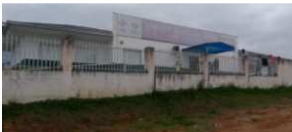
FACHADA POSTO DE SAÚDE OLIMPIO JOSE DA ROCHA
