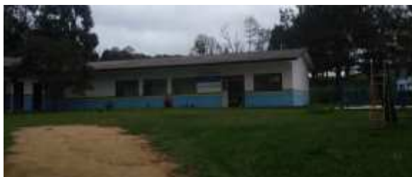
FACHADA POSTO DE SAÚDE ALFREDO RIEKE SOBRINHO
