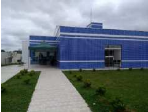
FACHADA POSTO DE SAÚDE CENTRAL I
