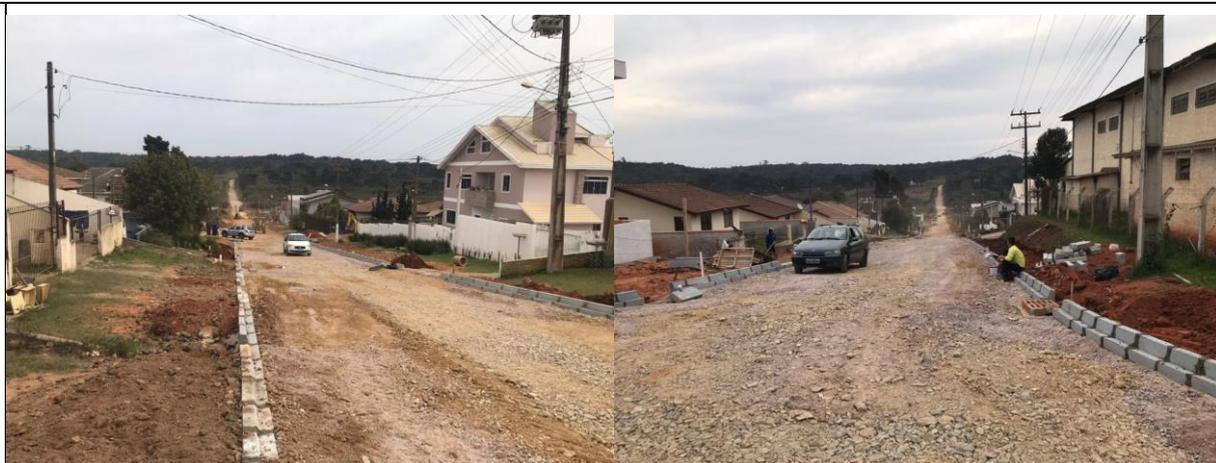
Foto 01/02 – Assentamento do meio-fio e execução da base.
