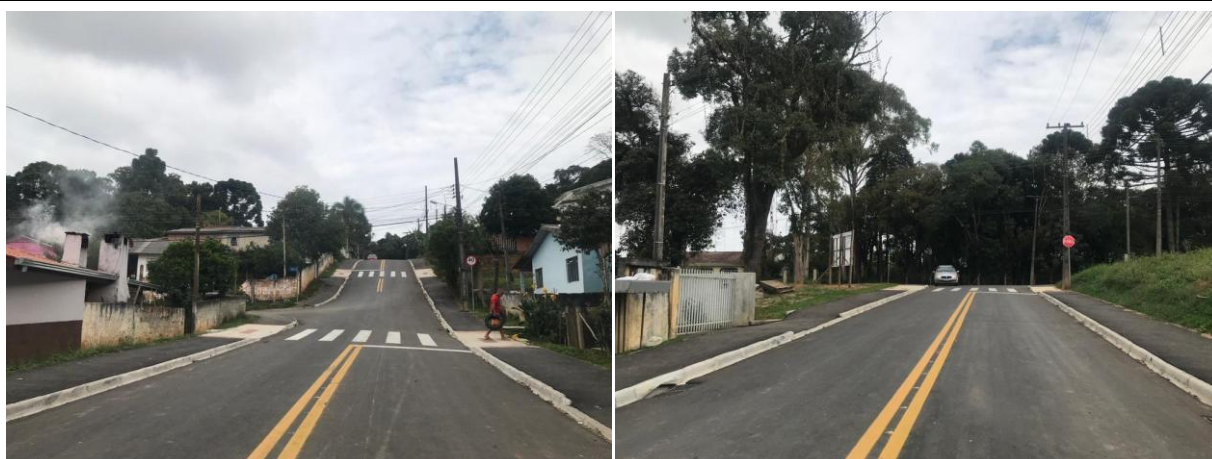
Foto 01/02 - Finalização do pavimento e calçadas.
