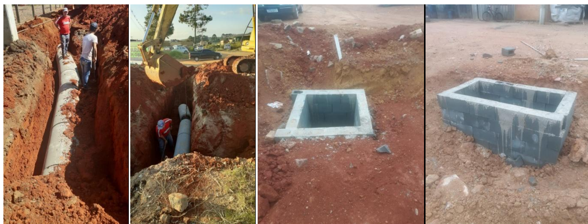
Foto 01/02/03/04 - Execução de drenagem.
