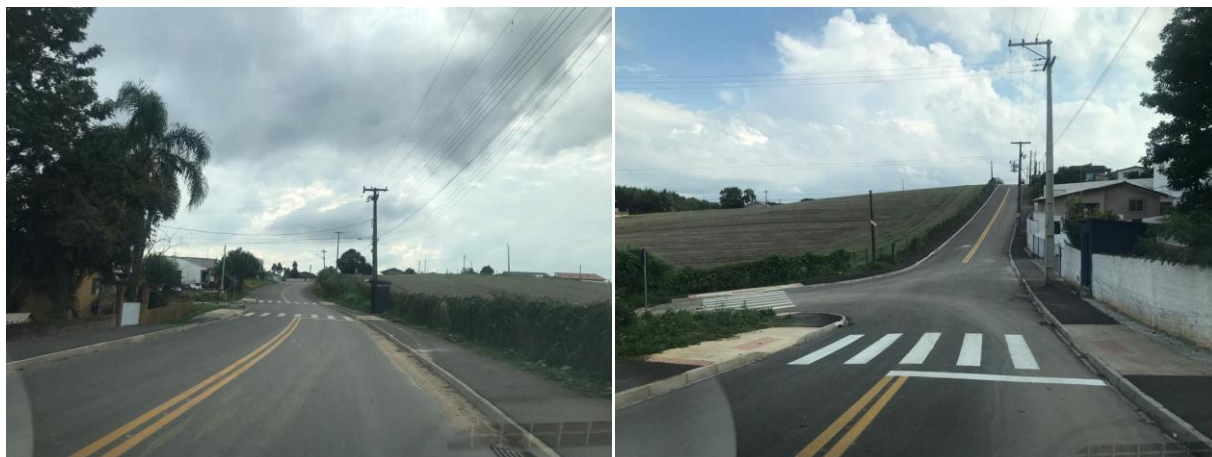
Foto 01/02 - Finalização do pavimento e calçadas.
