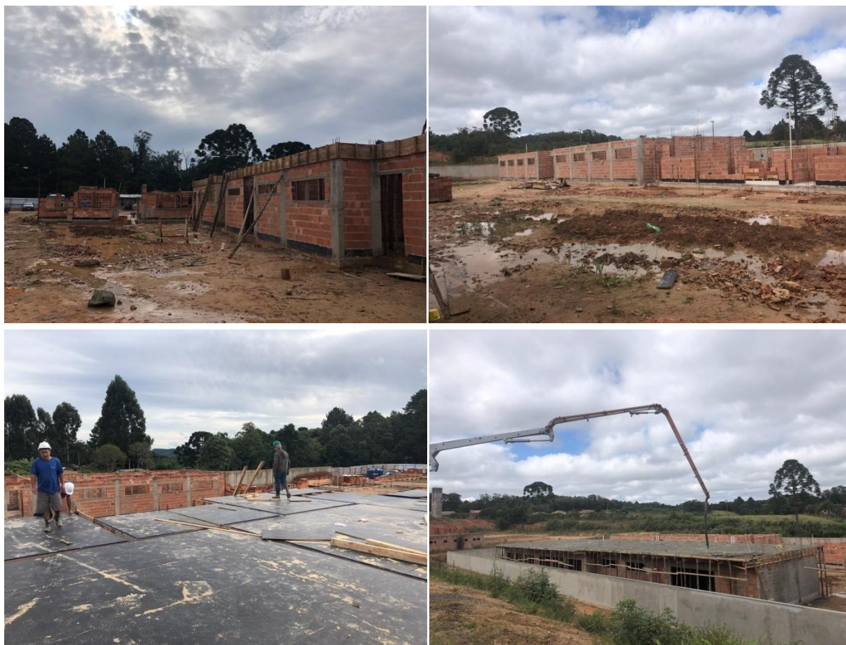
Foto 01/02 - Execução da alvenaria e concretagem da laje.
