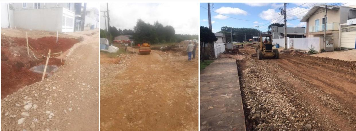
Foto 01/02/03 - Execução de drenagem e regularização da pista.
