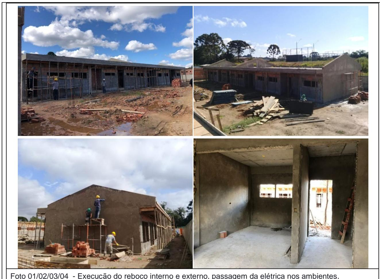
Foto 01/02/03/04 - Execução do reboco interno e externo, passagem da elétrica nos ambientes.
