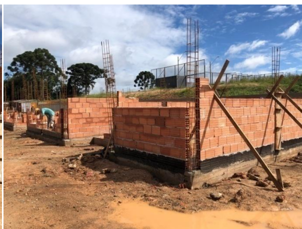
Foto 01/02 - Execução dos pisos, execução hidrossanitaria e execução da alvenaria.
