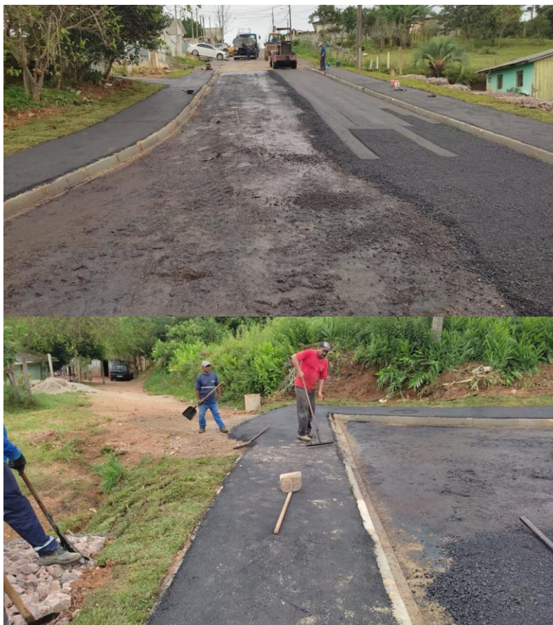
Foto 01/02 - Finalização do pavimento e calçadas.
