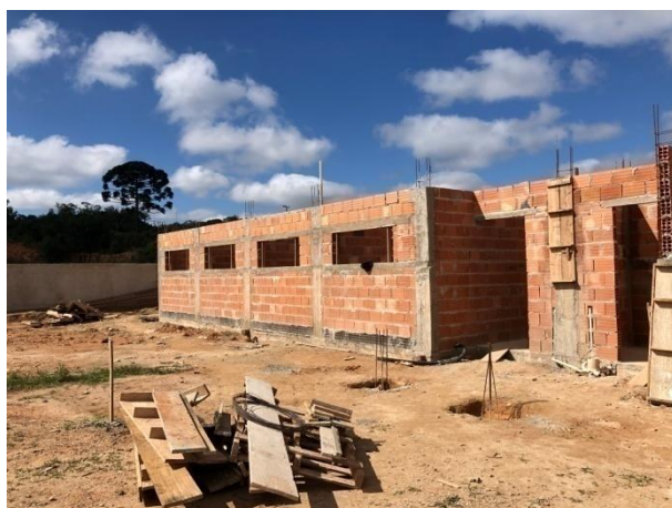
Foto 01/02 - Execução dos pisos, execução hidrossanitaria e execução da alvenaria.
