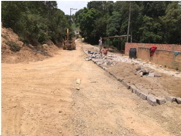
Foto 01/02 - Execução da pavimentação poliédrica.
