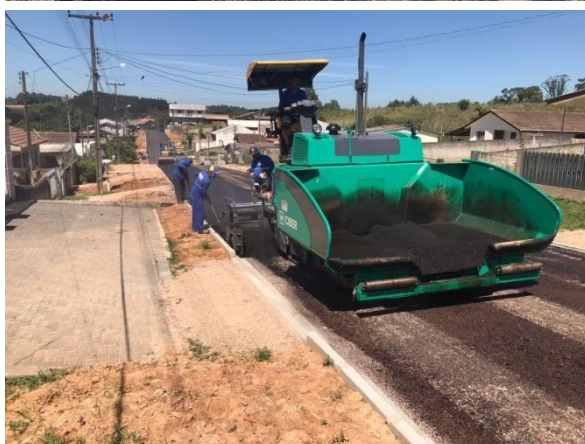
Foto 01/02/03/04 -Execução da pavimentação.
