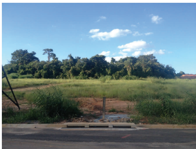
Figura 07— Vista da galeria de águas pluviais, na calçada do terreno de implantação com a rua Maria Aparecida Bernardes de Moraes
