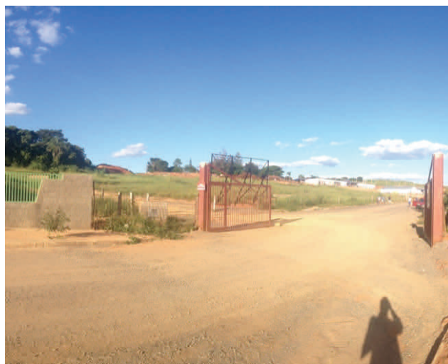
Figura 02— Vista da parte da rua Maria Aparecida Bernardes que não está pavimentada.
