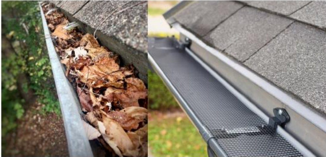
Fig. 12 - Calha cheia de folhas e calha com tela filtro instalada.
