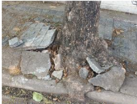
Fig. 9 - Calçada sem área permeável adequada. Fonte: Arquivo pessoal - Thaís Bargas, 2024.
