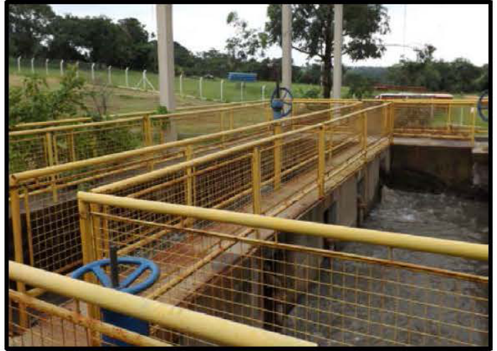
Figura 14. Canal de entrada do desarenador
