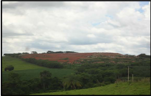
Figura 22. Encerramento do aterro controlado
