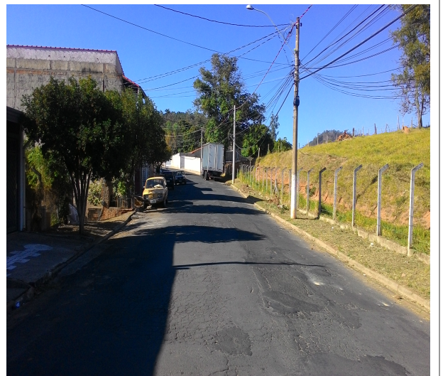
F 04 – Vista do trecho da Rua Luis Dalto.
