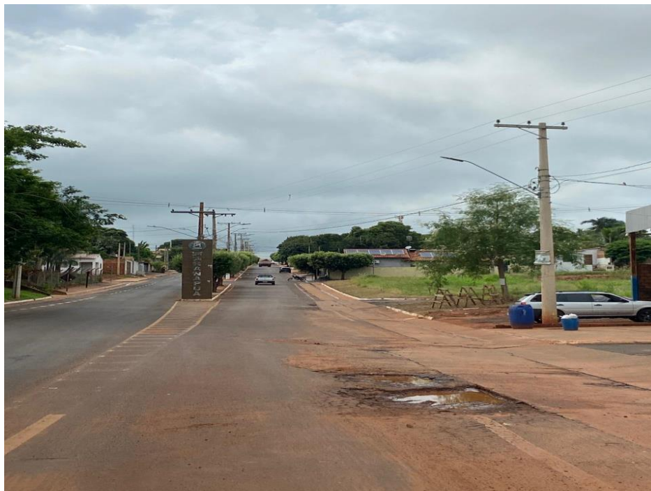
Prolongamento da Avenida Luizete entre a Rua Antônio Carrasco e Avenida Circular D
