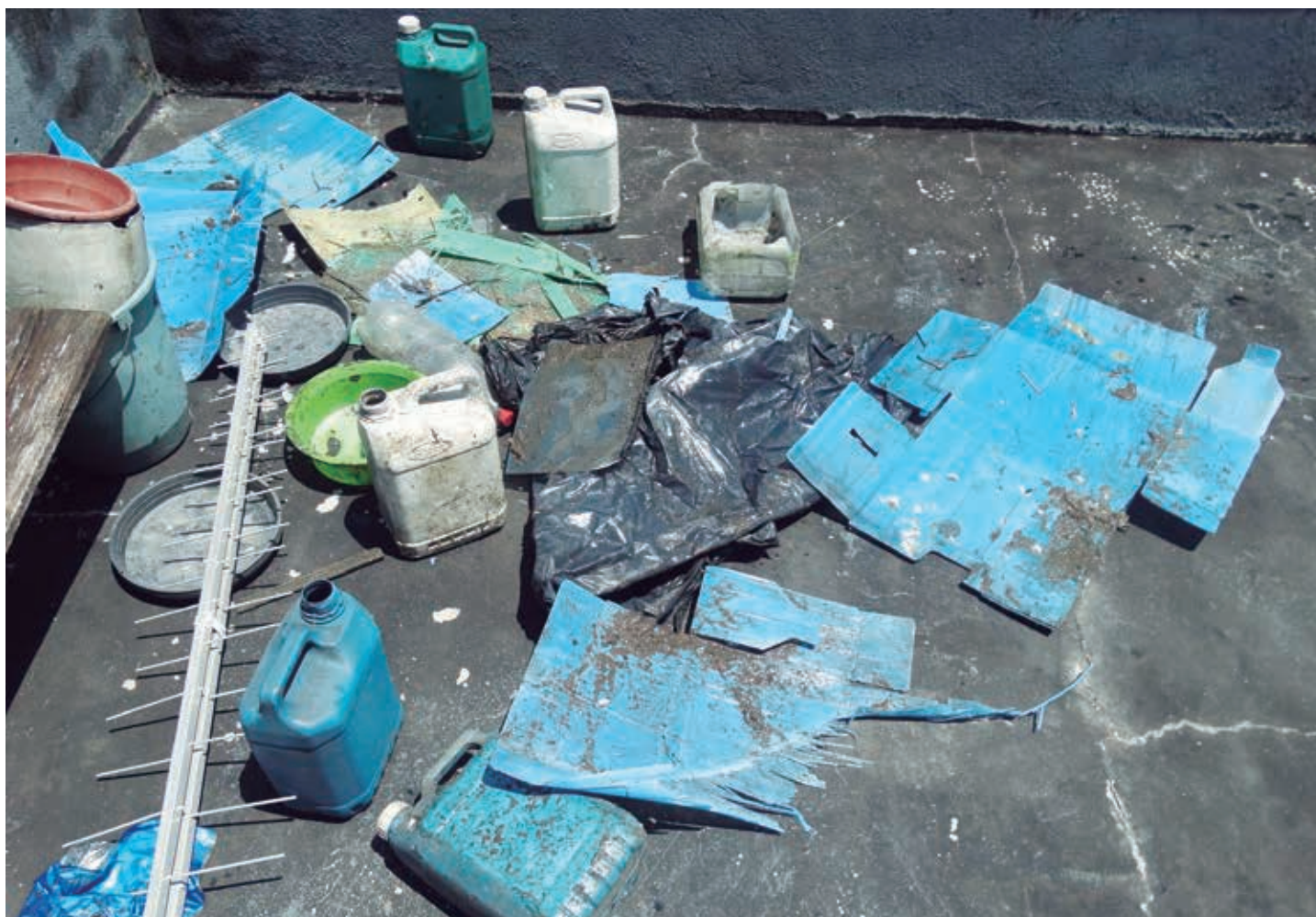
Lixo acumulado no teto do Centro Educacional estava obstruindo a passagem de águas pluviais
