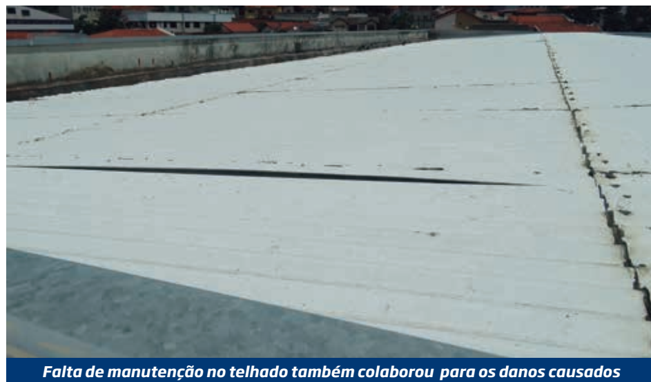
Lixo acumulado no teto do Centro Educacional estava obstruindo a passagem de águas pluviais
