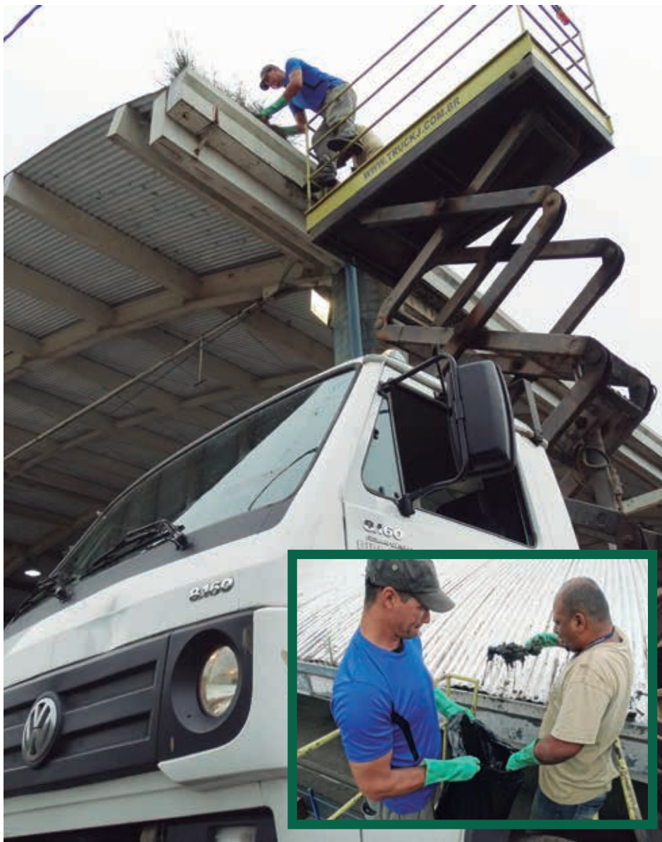
Funcionários da Secretaria de Obras e Serviços realizam a limpeza na calha do Terminal Rodoviário
