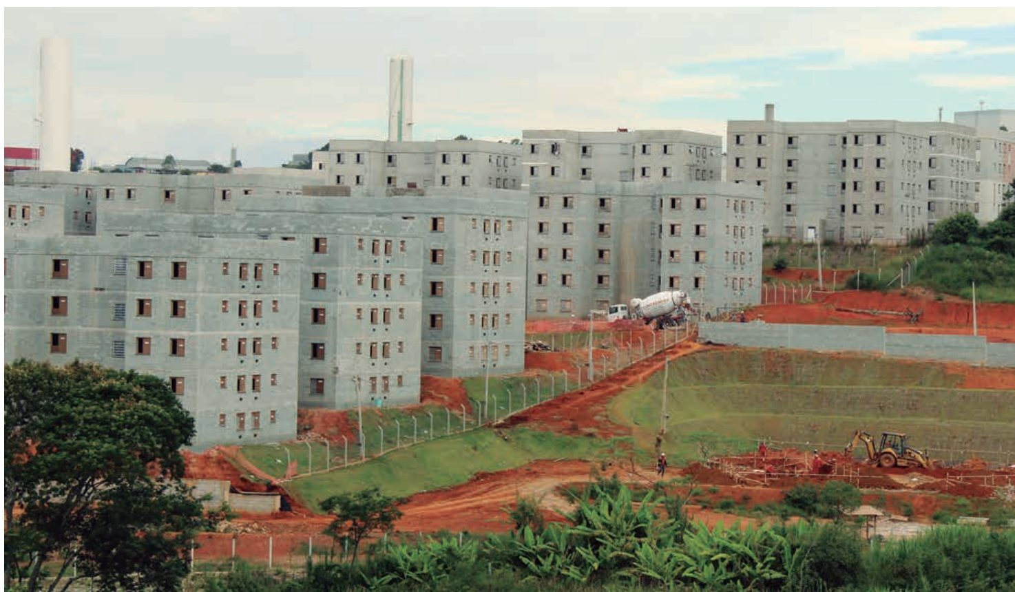
Além dos 1.100 apartamentos, o empreendimento contará também com uma estação de tratamento de esgoto, uma creche e uma escola de ensino fundamental
