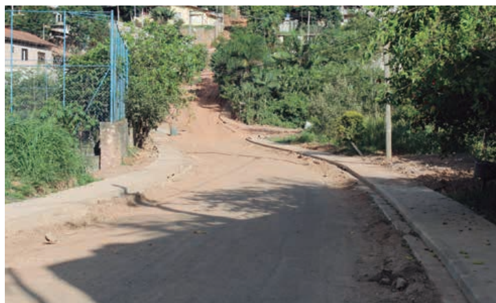
A instalação de guias e sarjetas está quase concluída na rua Golfinho no bairro Lagoa do Barreiro
