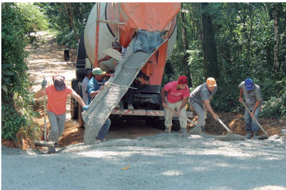
Serviço executado pelos funcionários da Secretaria de Obras
