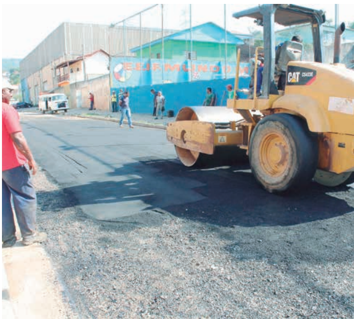
Rua Álvaro Simões no bairro do Colinas em Terra Preta
