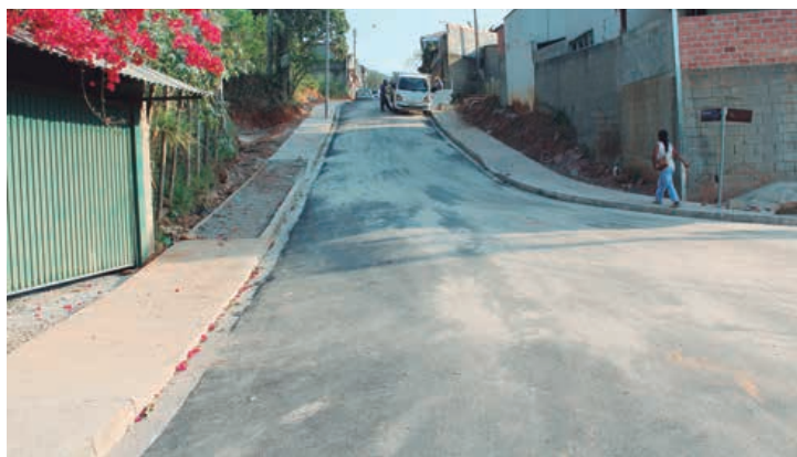
No bairro do Barreiro, a Prefeitura concluiu o asfalto das ruas Corvina e Tilápias
