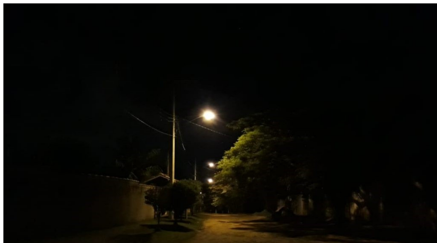
Lâmpadas trocadas no bairro Alvorada. Foto: Secretaria de Obras
