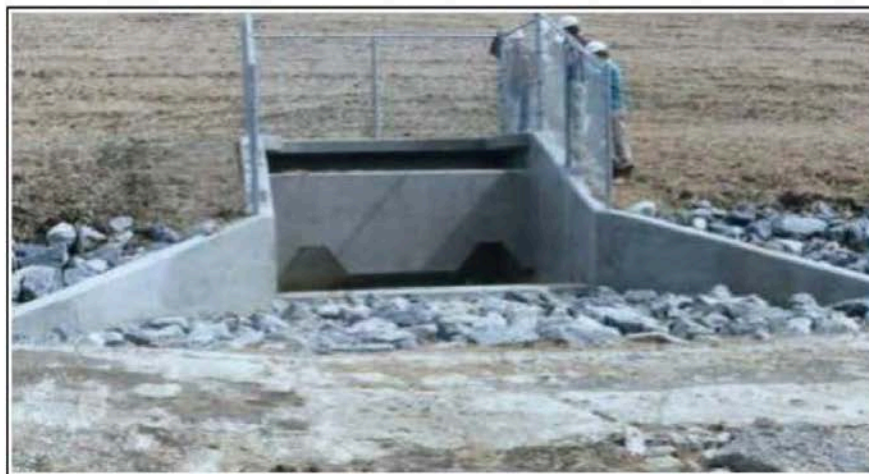
Figura 90 – Dissipador por bloco de impacto
