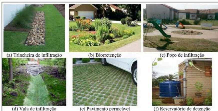
Figura 65 – Diferentes dispositivos de detenção e infiltração na fonte.
