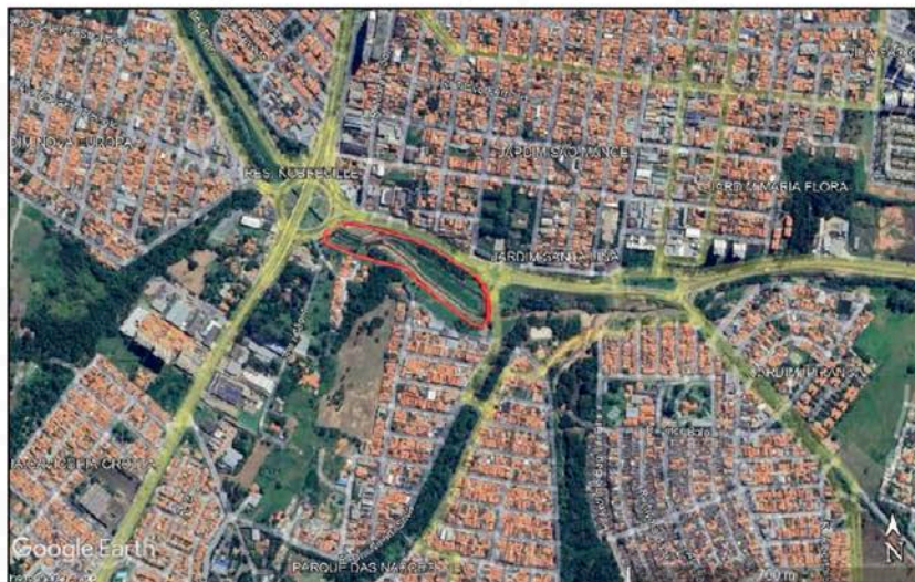
Figura 33 – Bacia de retenção do Parque das Nações.
