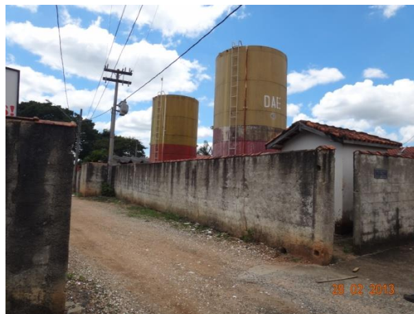
Foto 4.8 – Reservatórios Casa de Adução
