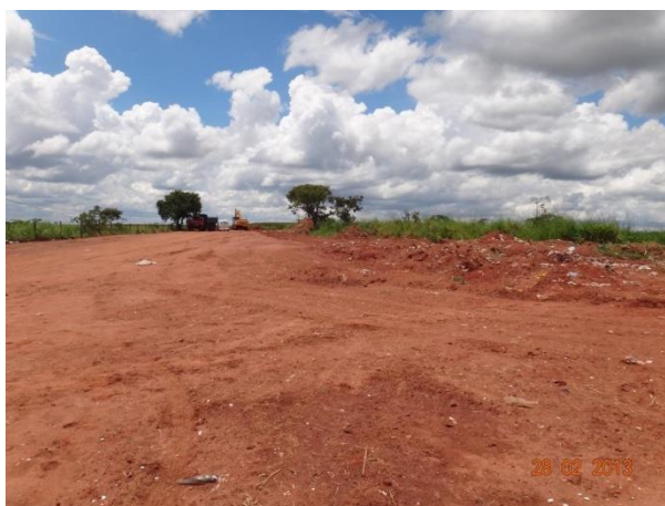
Foto 4.9 – Aterro em Valas
