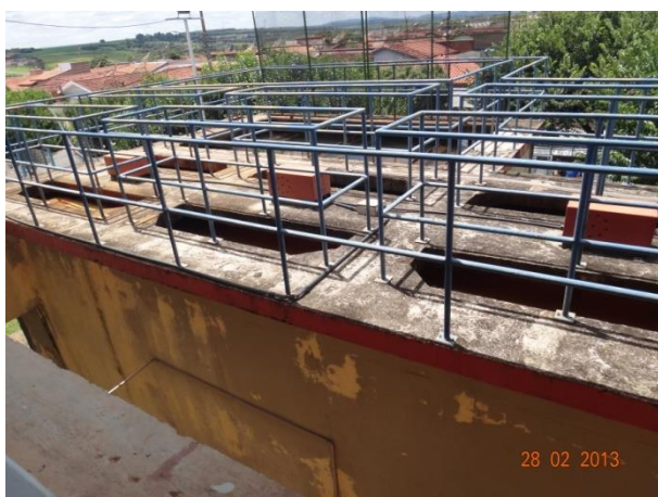
Foto 4.5 – Vista Geral da ETA
